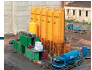
Suspensionslagerung Slurry storage
