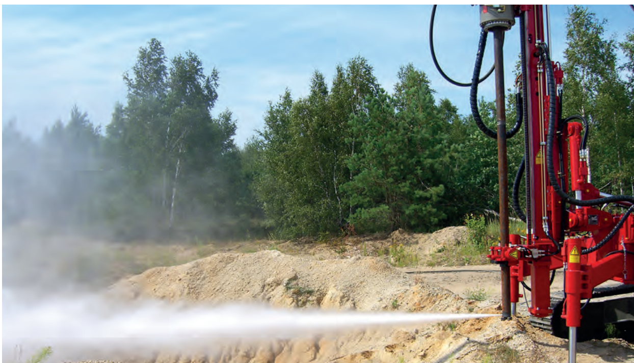
KLEMM HDI-Ausrüstung KLEMM jet grouting system
