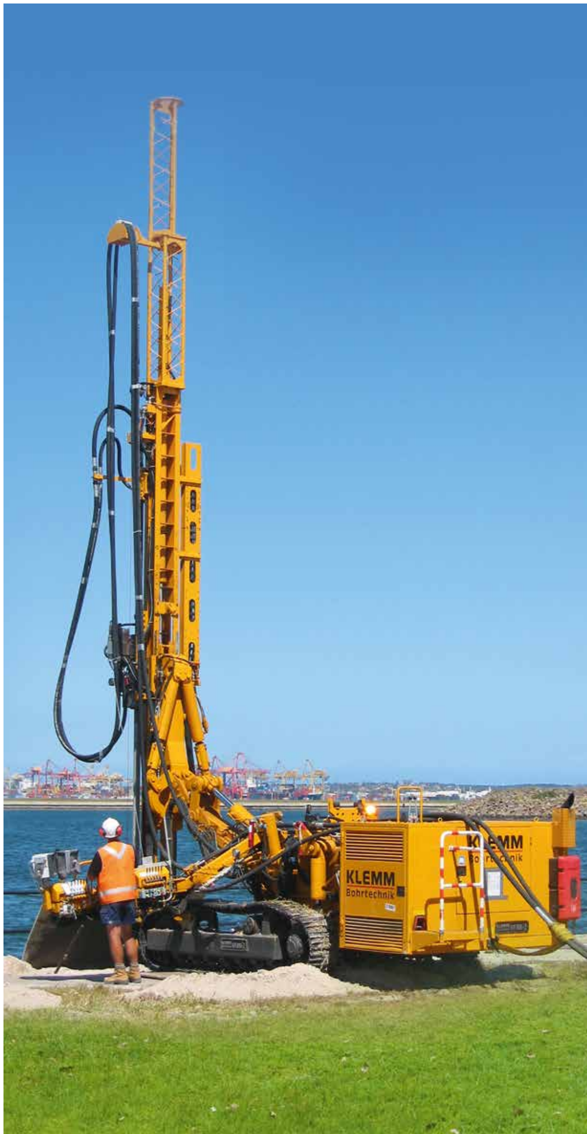
Hochdruckinjektionen High-pressure injections
