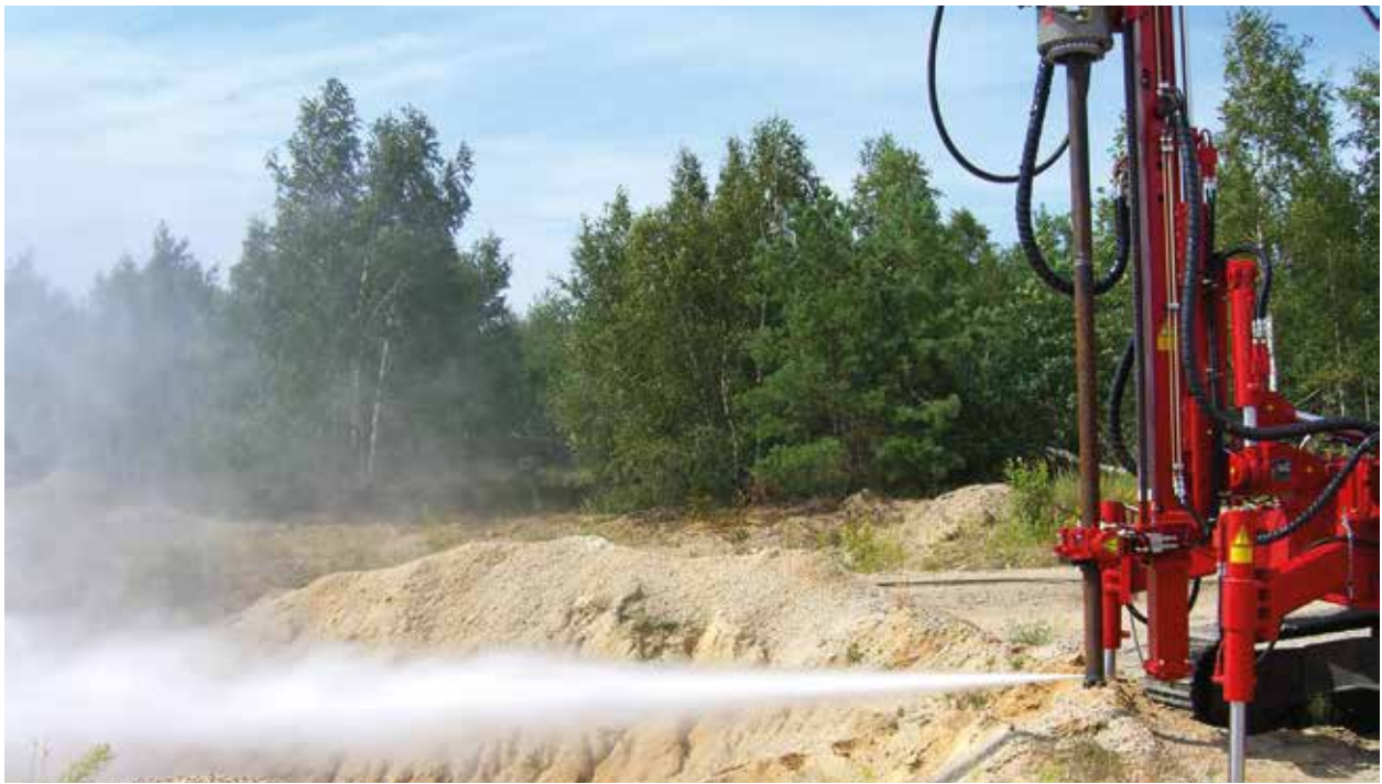
KLEMM HDI-Ausrüstung KLEMM jet grouting system
