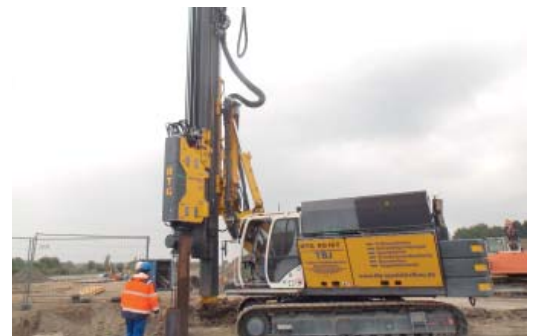
RG 16T mit MR 130AVM bei Spundwandarbeiten RG 16T with MR 130AVM during sheet pile driving
