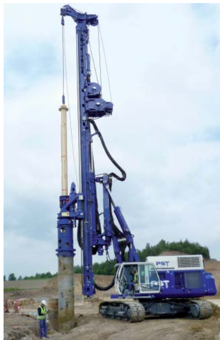
Kellybohrverfahren mit RG 18 S Kelly drilling mode on RG 18 S
