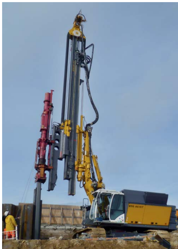
RG 19 T mit Dieselhammer zum Einbringen von Spundwänden RG 19 T with diesel hammer for driving sheet piles
