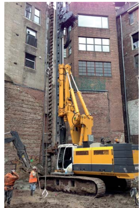
SOB Pfahlherstellung mit RG 25 S CFA piling with RG 25 S
