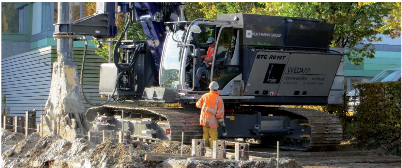
CSM Einheit BCM 5 an RG 19 T CSM unit BCM 5 on RG 19 T
