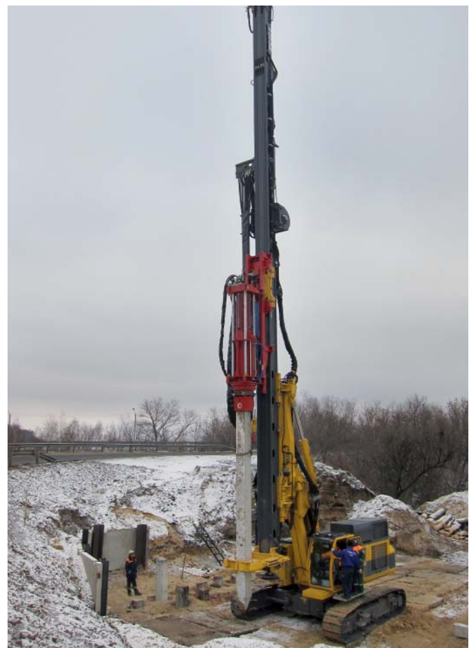
RG 22 S mit FAMBO Hydraulikhammer RG 22 S with FAMBO hydraulic hammer
